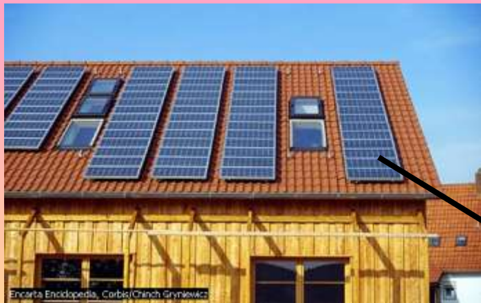
Montaggio con inclinazione 30° direzione Sud
